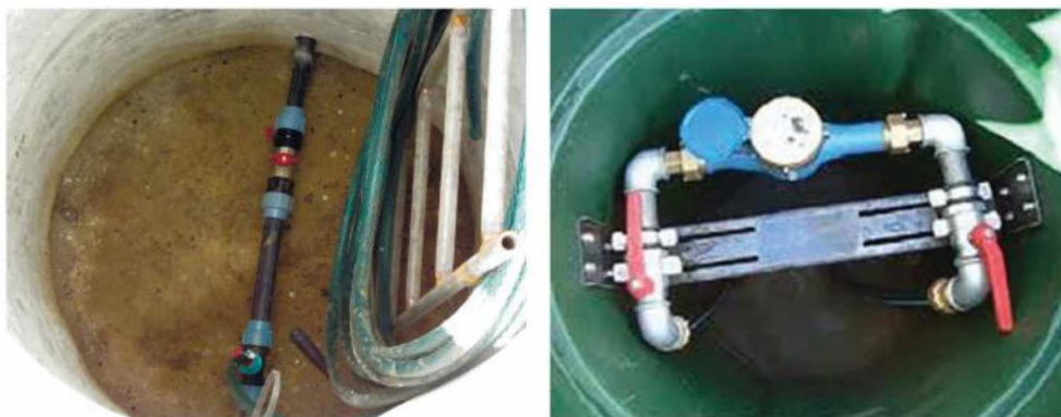
Рис. 11.7. Приклади влаштування вузлів вводу в колодязі
